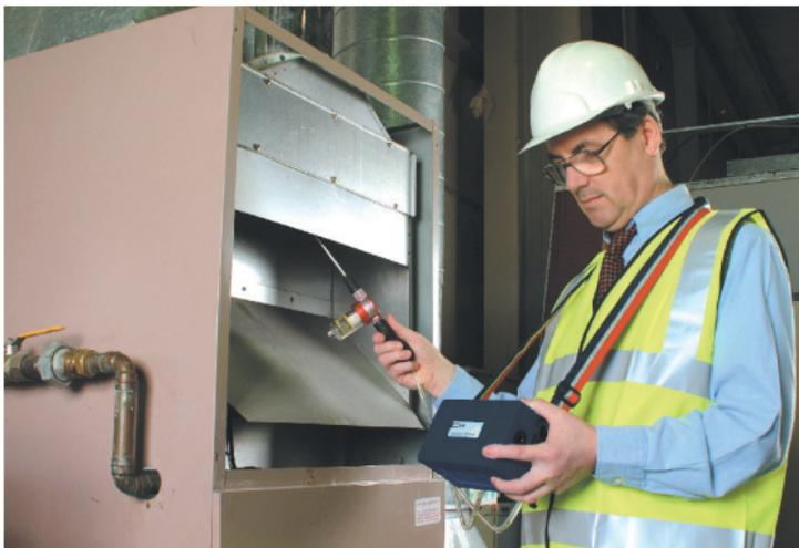
*Fig. C-8 Flue Probe*
